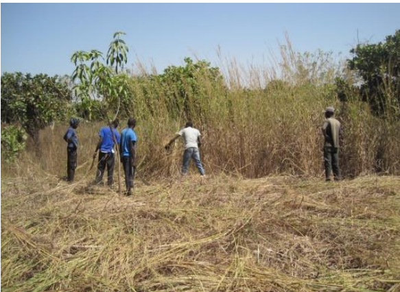
In Latriya musste vor Beginn der Bauarbeiten das Projektgelände gerodet werden.
