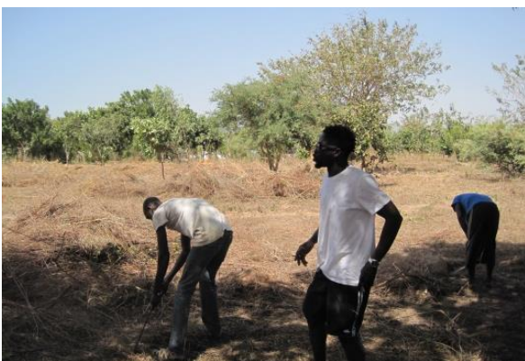
Die Bauarbeiter begnügen sich mit einfachsten Geräten und arbeiten gänzlich ohne Baumaschinen.
